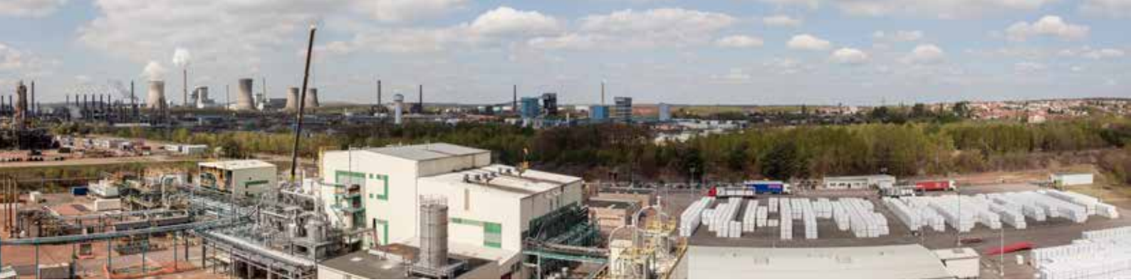
Vue générale de l'unité de polystyrène depuis les silos PS.
